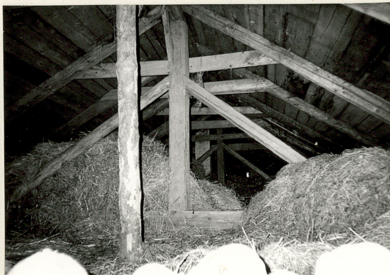
konstrukcja więźby dachowej
