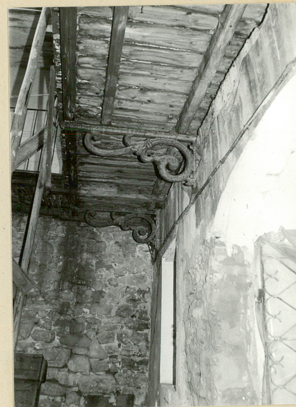
konstrukcja nośna galerii od podwórza
