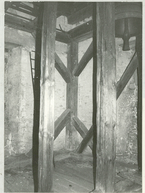
konstrukcja nośna kondygnacji dzwonowej
