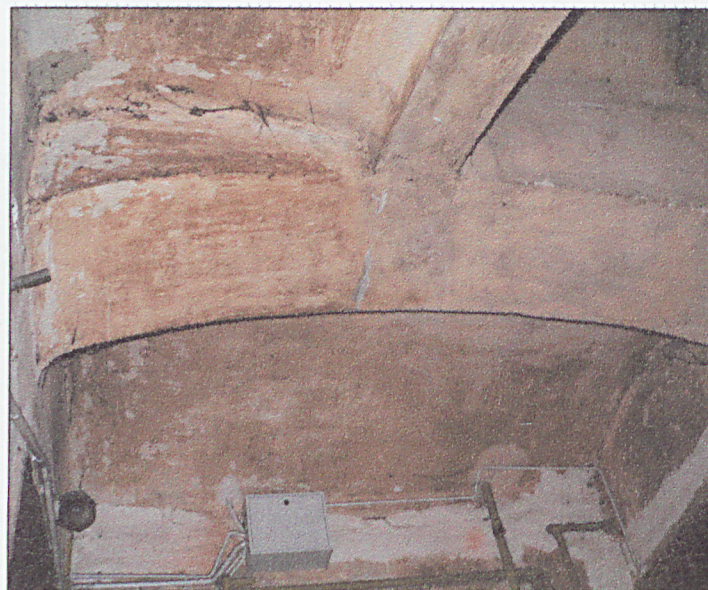
Skrzydło północne. Klatka schodowa. Konstrukcja biegów schodowych
