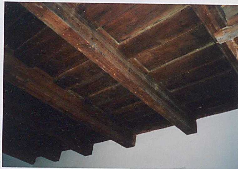
Fot. 17. Fragment stropu nagiego nad środkowym помещением tylnego członu budynku.
