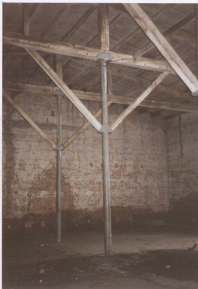
il. 13 Konstrukcja nośna dachu
