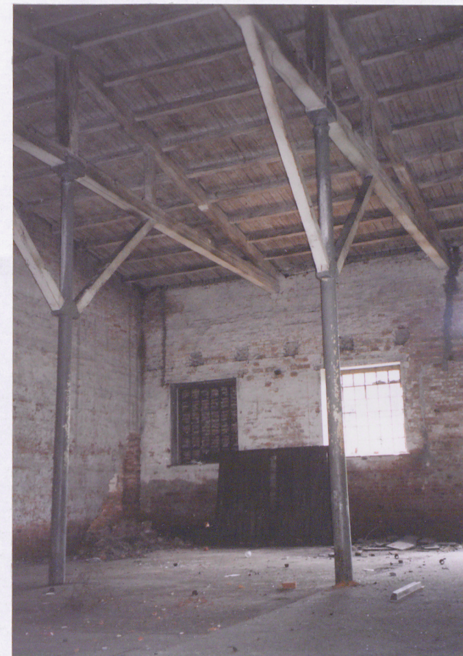
il. 14 Konstrukcja nośna dachu
