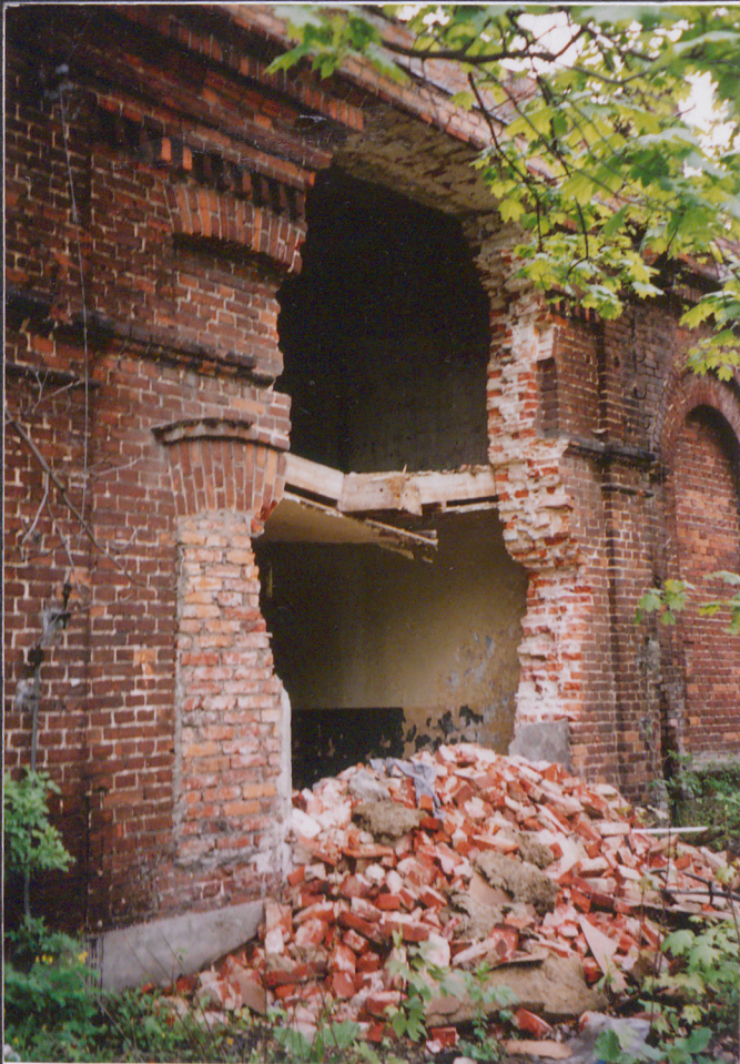
il. 10 Kraniec elew. wsch. – zniszczenia po niekontrolowanych penetracjach magazynu
