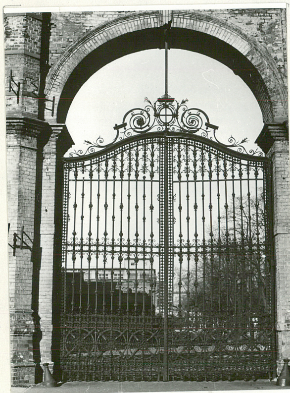
1. Kuta żelazna krata w części środkowej bramy przejazdowej
