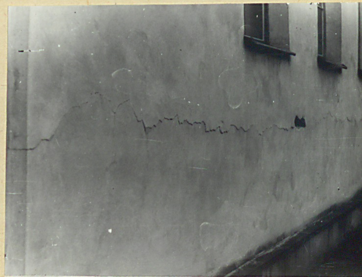
Fot.4.Pęknięcie wzdłużne muru
