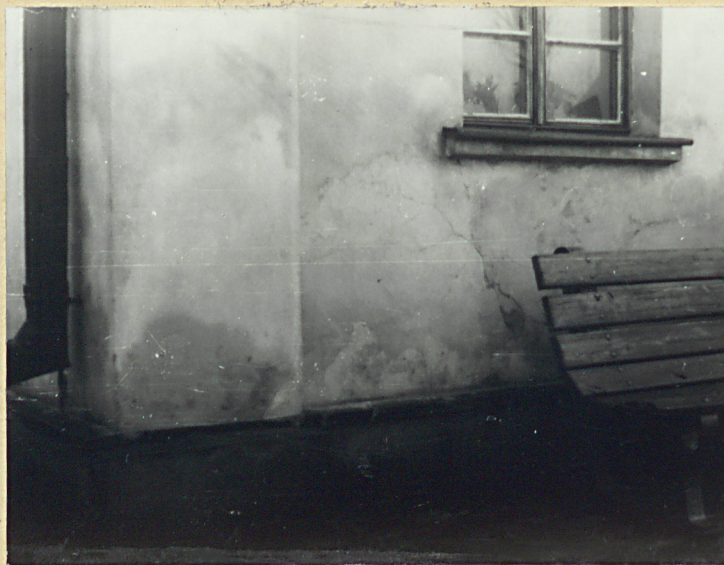
Fot.2 i 3.Uszkodzenia muru - rysy podokienne
