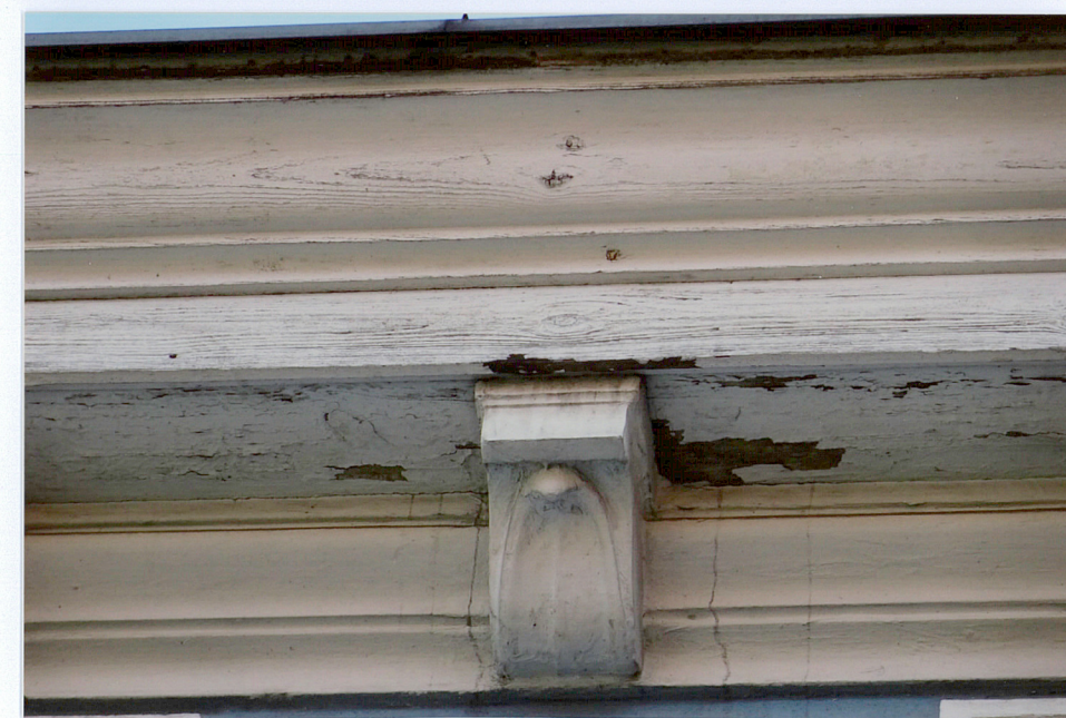
Fragment drewnianego gzymsu podokapowego elewacji frontowej
