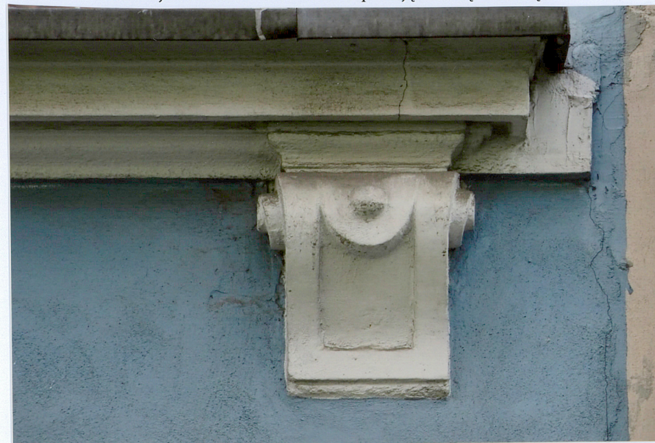
Elewacja frontowa – konsolka wspierająca ławę okienną
