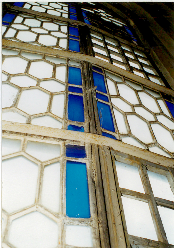
Fot. [5] Fragment konstrukcji okna oryginalnego - widać, że okno pierwotnie miało dwa rozwieralne skrzydła, pomiędzy skrzydłami jest słupek z fragmentem zakrętki; później okno przekształcono w stałe - osadzając poziomo stalowe kątowniki pomiędzy poziomymi kwater. Dwie kwatery są uzupełnione wtórnie oknami krosnowymi pojedynczymi, drewnianymi z szczelinami krzyżowymi.
