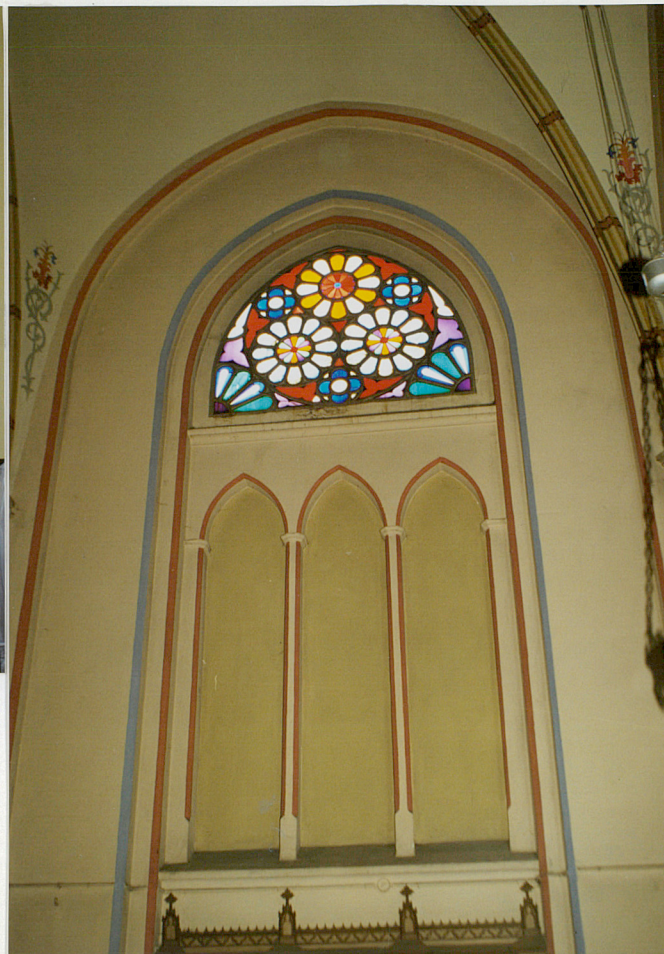
Fot. 24 Artykulacja jednego z przęseł prezbiterium: nad drzwiami do zakrystii ślepe tryforium, a nad nim tej samej szerokości otwór okienny z oryginalnym wypełnieniem.
