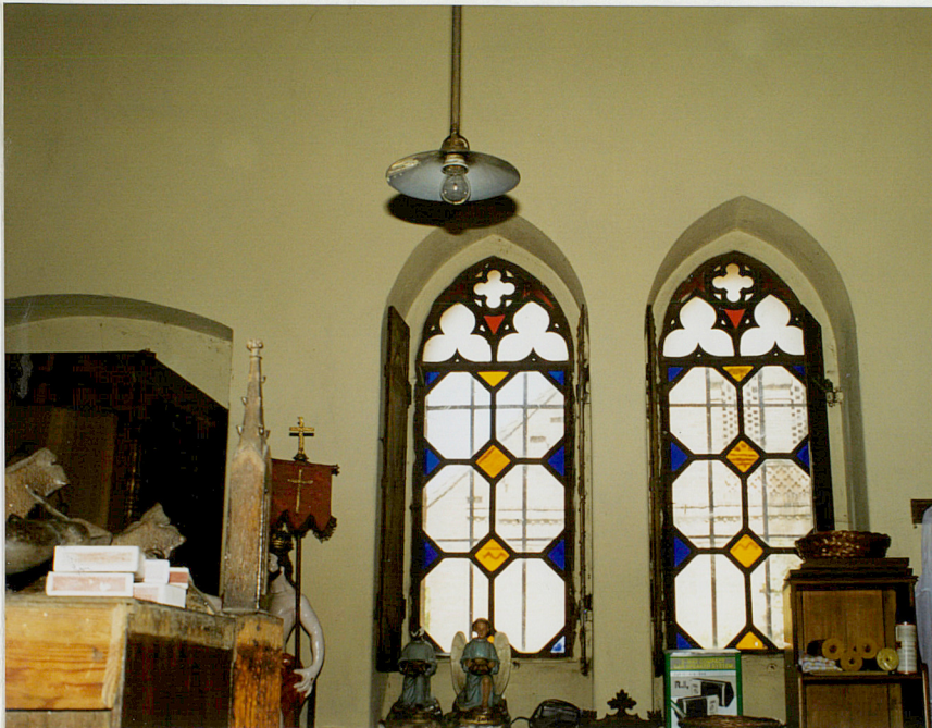
Fot. 23 Otwory okienne zakrystii widok od strony wnętrza: wypełnione podobnie jak okna kościoła żeliwnymi oknami pojedynczymi odlewanyymi i dodatkowo z okiennicami wewnętrznymi.
