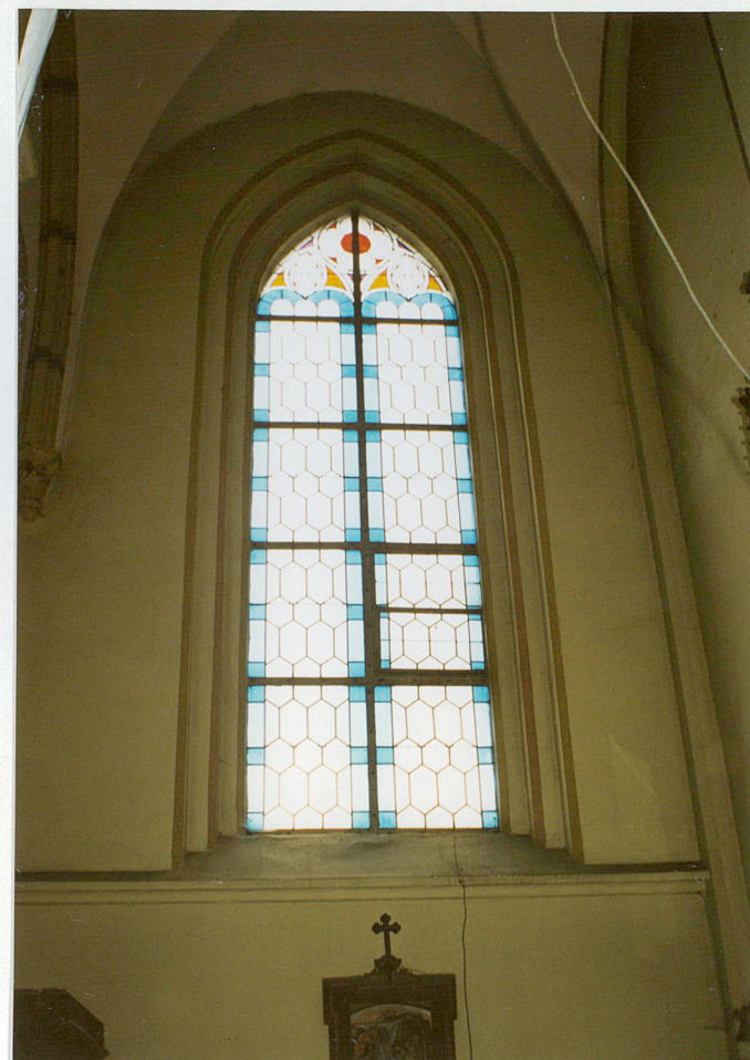
Fot. [5] Fragment konstrukcji okna oryginalnego - widać, że okno pierwotnie miało dwa rozwieralne skrzydła, pomiędzy skrzydłami jest słupek z fragmentem zakrętki; później okno przekształcono w stałe - osadzając poziomo stalowe kątowniki pomiędzy poziomymi kwater. Dwie kwatery są uzupełnione wtórnie oknami krosnowymi pojedynczymi, drewnianymi z szczelinami krzyżowymi.
