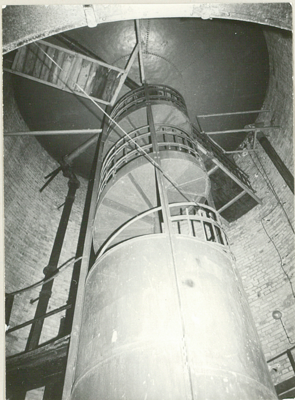
1. I kondygnacja. Schody stalowe w rurze wiodącej na pomost pod zbiornikiem /wyżej drabina stalowa/
