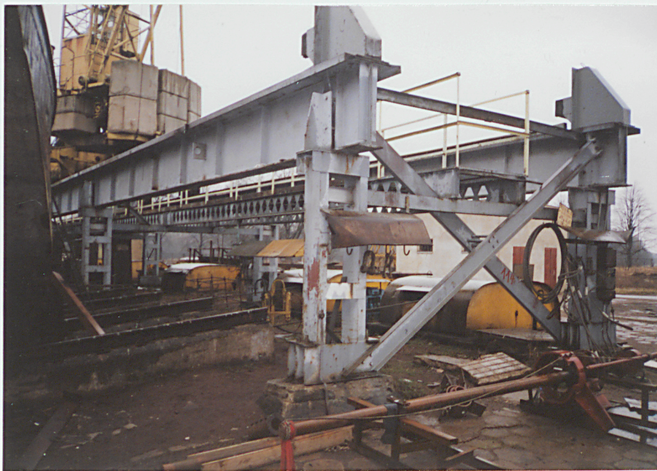
4. Estakada z windami wyciągowymi pochylni, neg. 1100/947/3.
