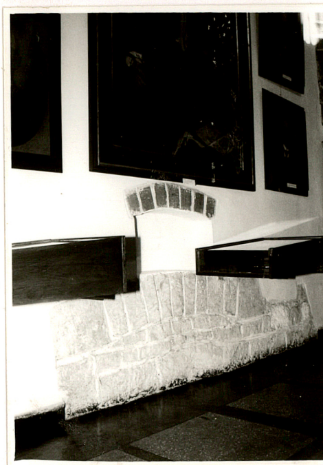
Wnętrze – V, VI kondygnacja użytkowa, fragmenty wątku, odsłonięte w trakcie badań architektonicznych Bramy.
