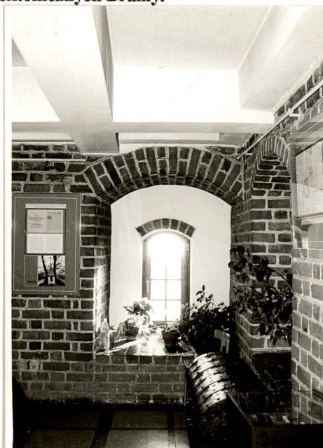
Wnętrze – II - III kondygnacja użytkowa, okna i przekształcone strzelnice
