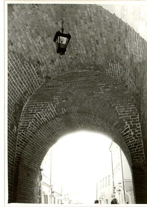
Dolna kondygnacja Bramy – sklepienie przejazdu.
