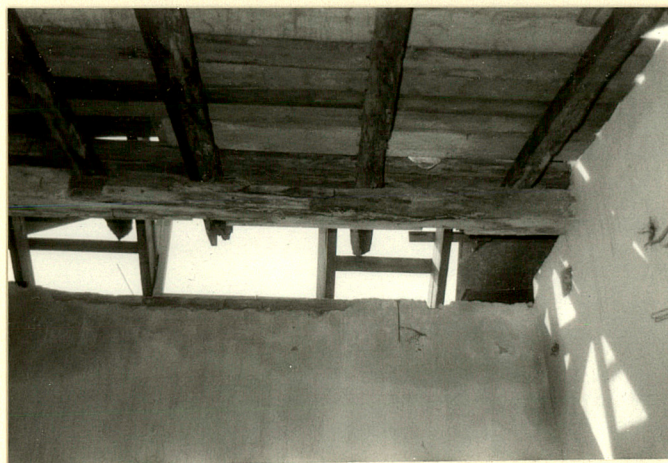
fot.9 Fragm. dawnego stropu drewnianego
