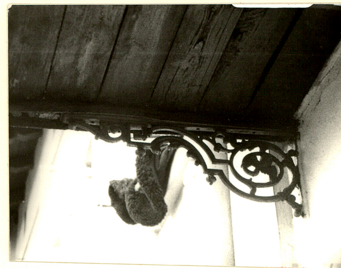
fot.12 Żeliwny wspornik balkonu od str. pn.
