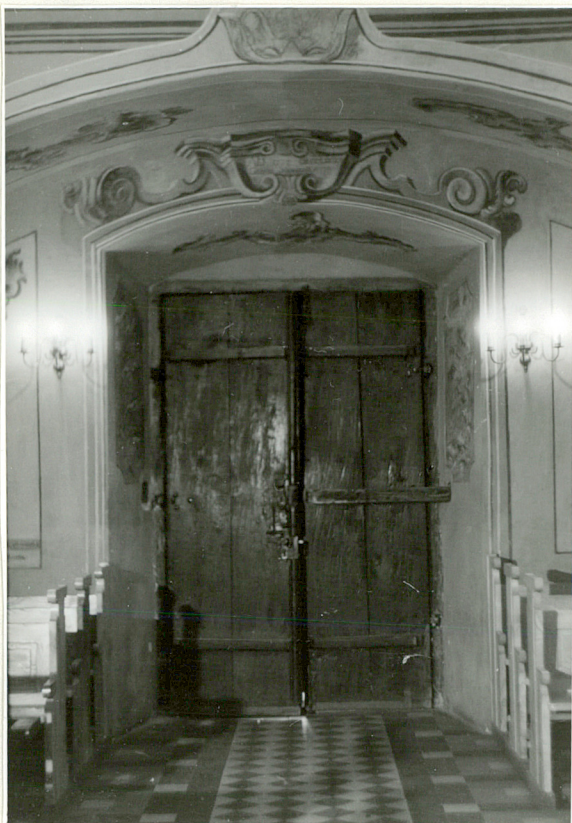
Drzwi do nawy głównej zamykane wysuwającym drągiem
