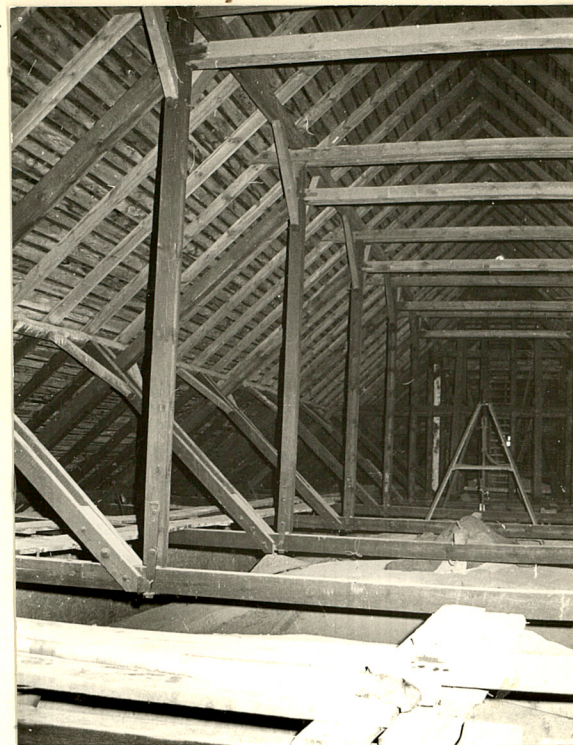
Więźba dachowa nad nawą gł.
