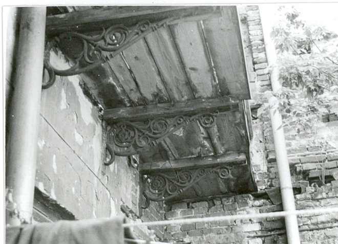
2. Oficyna – fragment galerii komunikacyjnej. Płyta wsparta na żeliwnych konsolach.
