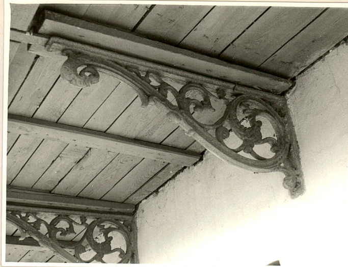
Żeliwny wspornik balkonu elewacji front.
