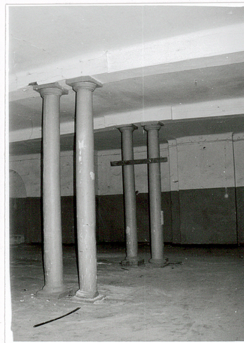
słup wspierający strop dolnej kondygnacji
