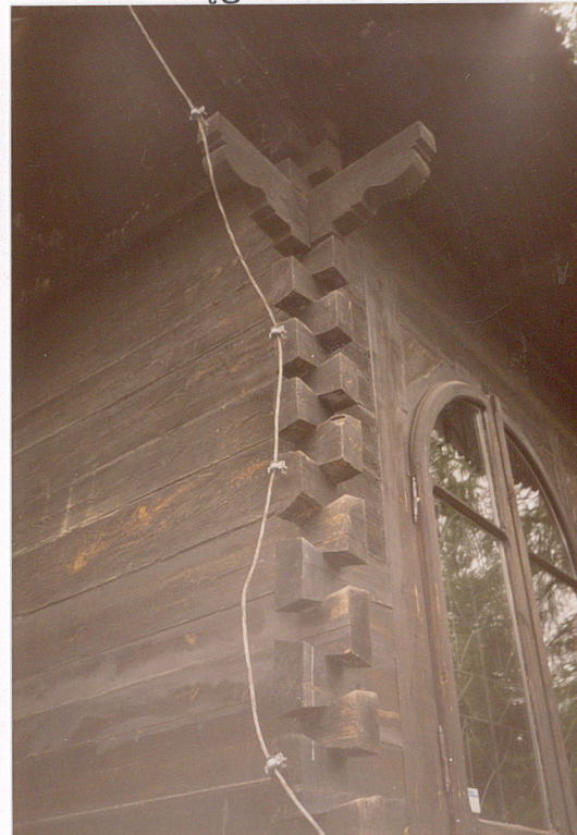
Fot.8.Zwęgłowanie ścian.
