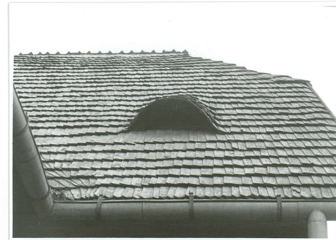
powieka w płn. połaci dachowej
