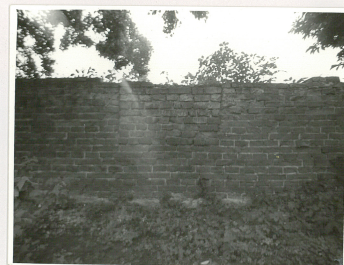
Fragment muru pd.-wsch. z zamurowanym otworem okiennym.
