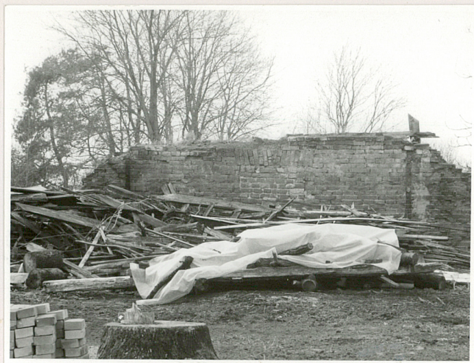
Fragment muru pd.-wsch. z zamurowanym otworem.
