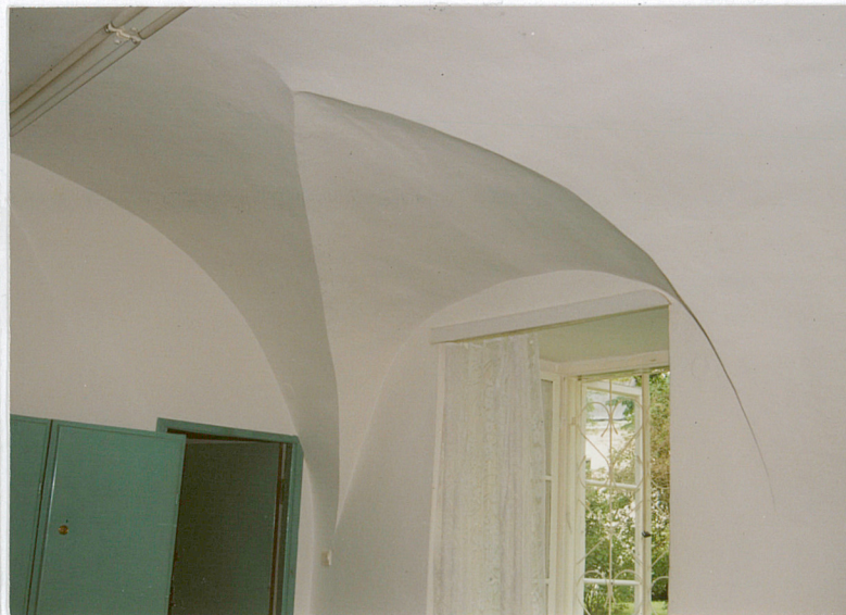
SKLEPIENIE KOLEBKOWE Z LUNETAMI
