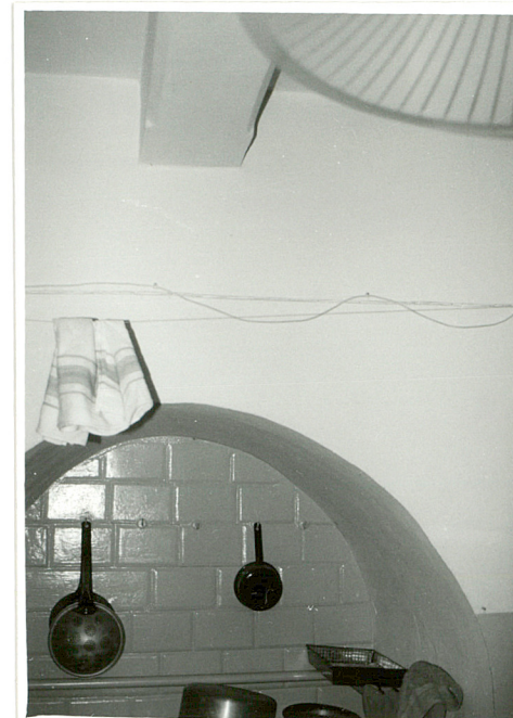
3. Wnętrze – замуrowana arkada kominowa.
