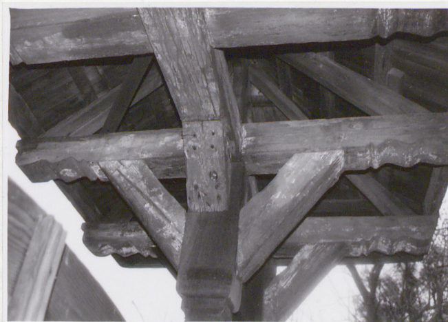
konstrukcja dachowa bramy
