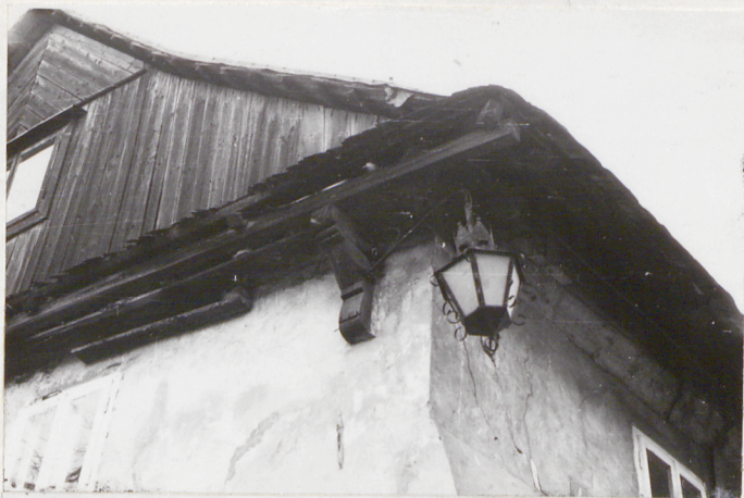
Detal okapu z ozdobnym kroksztynem
