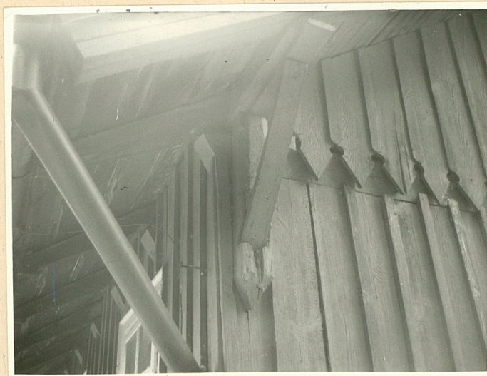
fot. 3 Fragment konstrukcji i oszalowania naroża od frontu
