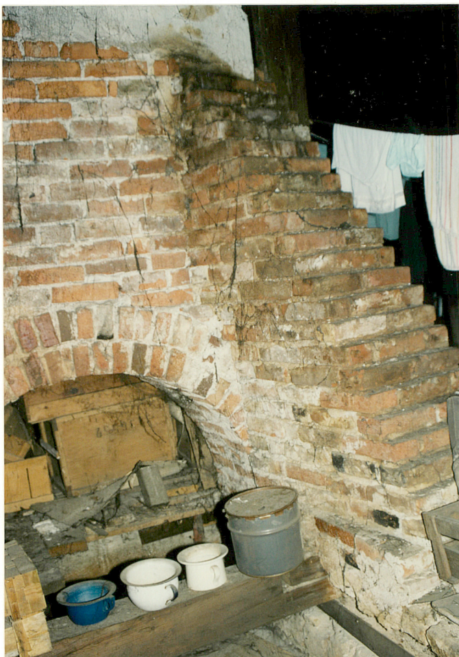
Fragment więzby dachowej Komin arkadowy na poddaszu
