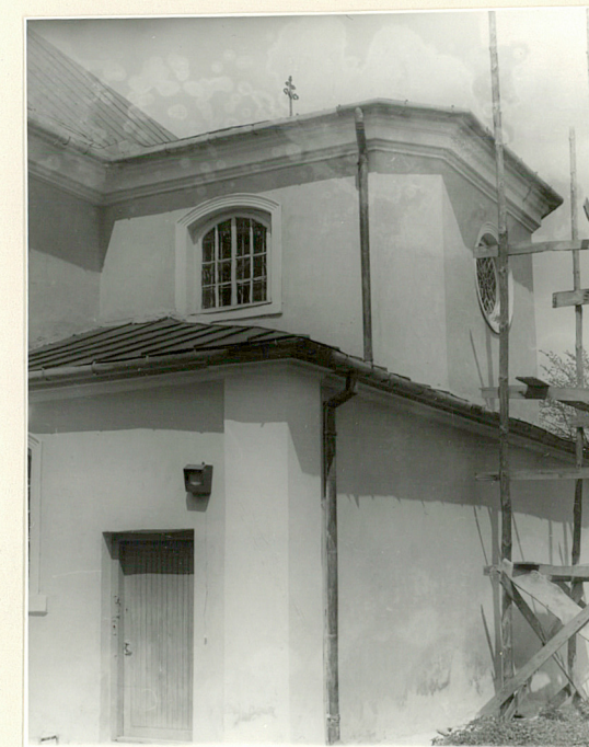
Prezbiterium, w dolnej partii ukryte pozostałości świątyni z XIIIw., powyżej nadbudowa z XIXw.
