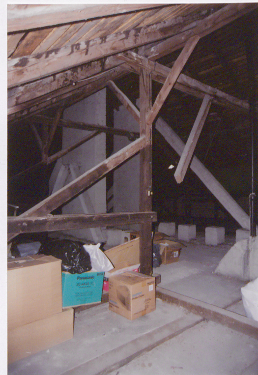
Poddasze i więźba dachowa
