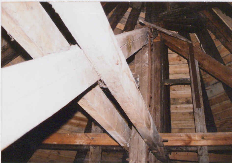
16. Widok ogólny na konstrukcję więźby dachowej. Kleszcze i zastrzały usztywniające słup centralny.
