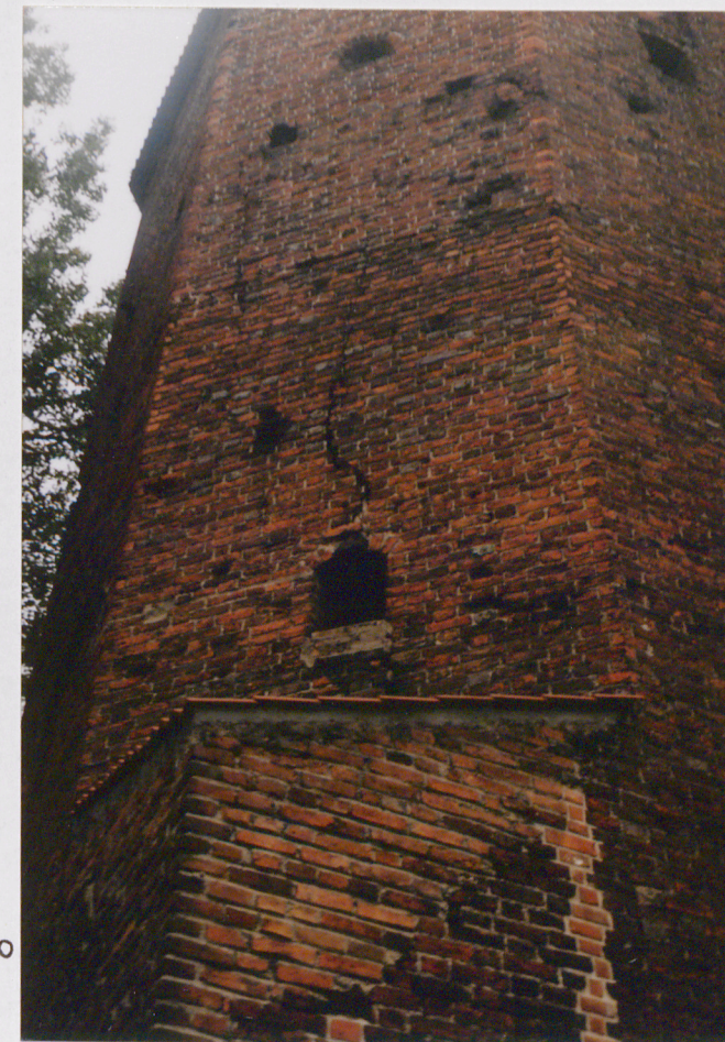
6. Zniszczenia zachodniego muru wieży. Wzór ODZ 1978 r.
