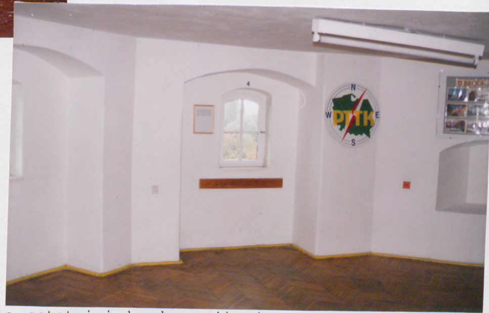
15. Pomieszczenie ostatniej kondygnacji wieży. Otwory okienne umieszczone wprostokątnych wnękach zamkniętych łukiem odcinkowym.
