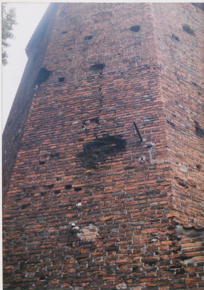
7. Zniszczenia zachodniego muru wieży.
