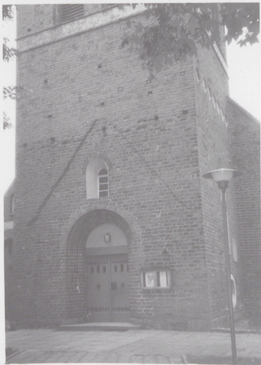
2. Fasada partia wieży z portalem i śladem dachu zniesionej kruchty.
