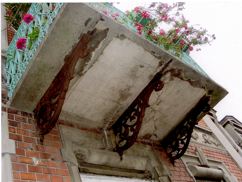
ELEWACJA POŁUDNIOWA, METALOWE WSPORNIKI BALKONU
