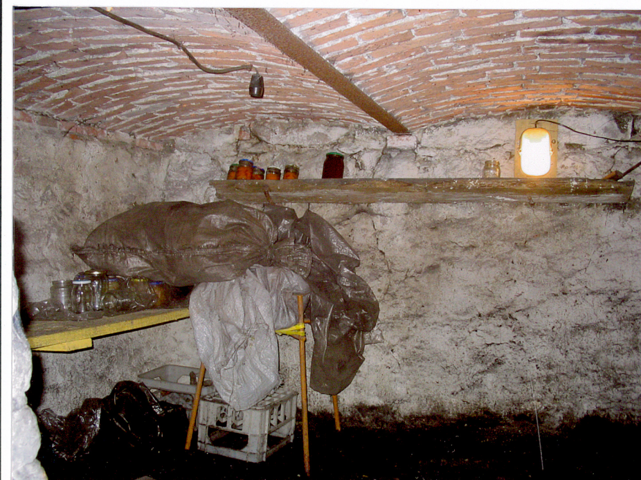
PIWNICA, WIDOCZNY STROP ODCINKOWY KLEINA
