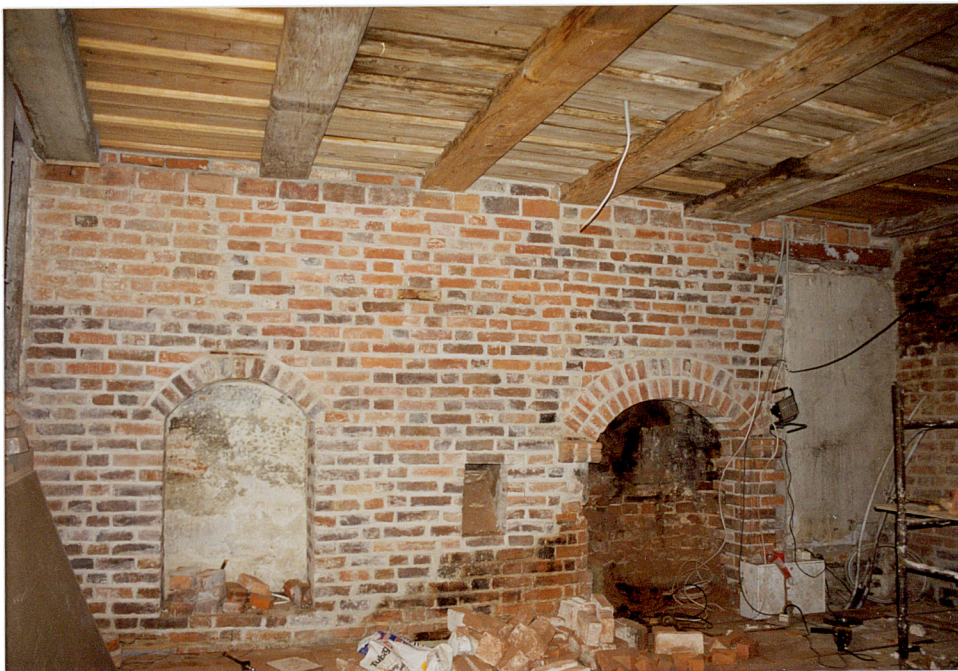
I piętro, mur wsch. z gotycką wnęką (z lewej) i nowożytnym kominkiem (z prawej). W narożniku zamurowane przejście z poddasza odwachu.
