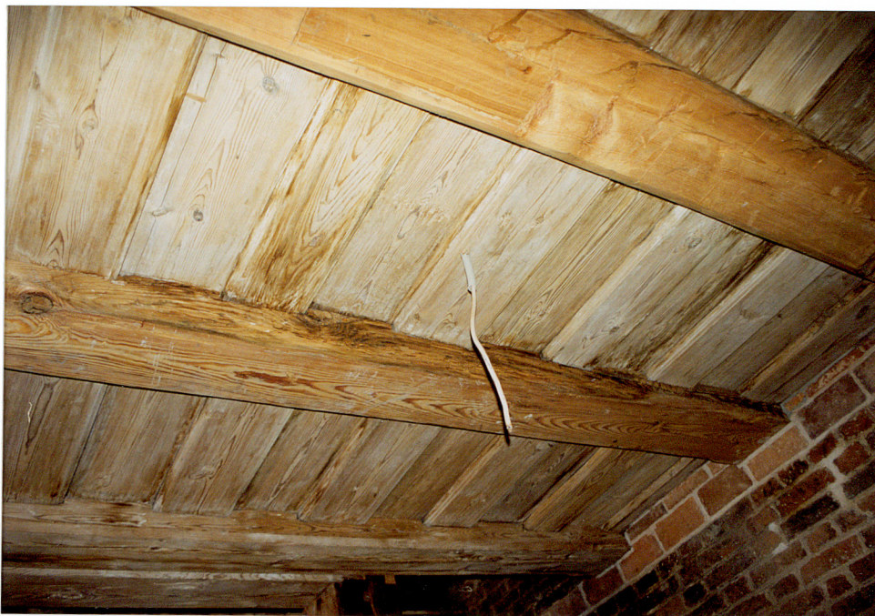
Strop belkowy wsuwkowy (XIX w.) umieszczony na I piętrze.
