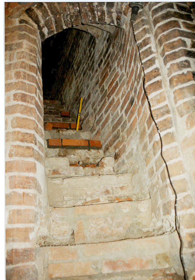
II piętro, mur zach.. Wejście umieszczone w obszernej strzelnicy, na schody prowadzące w grubości muru na poddasze (niegdyś ganek).
