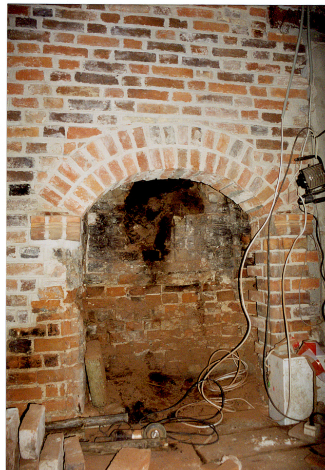
I piętro, mur wsch.. Nowożytny kominek częściowo zrekonstruowany.
