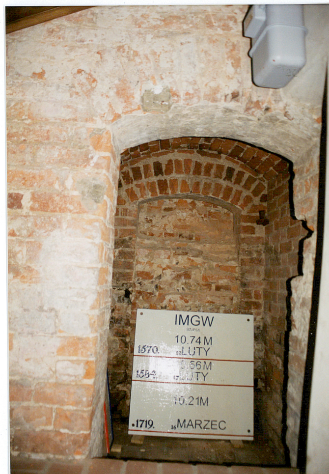
Średniowieczne przejście łączące przejazd z ówczesnym odwachem, zamurowane w XIX w.. Widok od strony wsch., z klatki schodowej obecnego odwachu.
