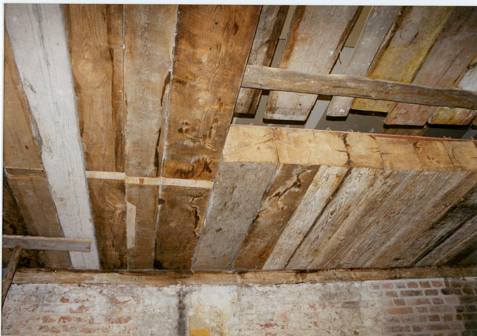
II piętro. Strop brusowy, prawdopodobnie gotycki, z wyciętym współcześnie otworem przeznaczonym na świetlik.
