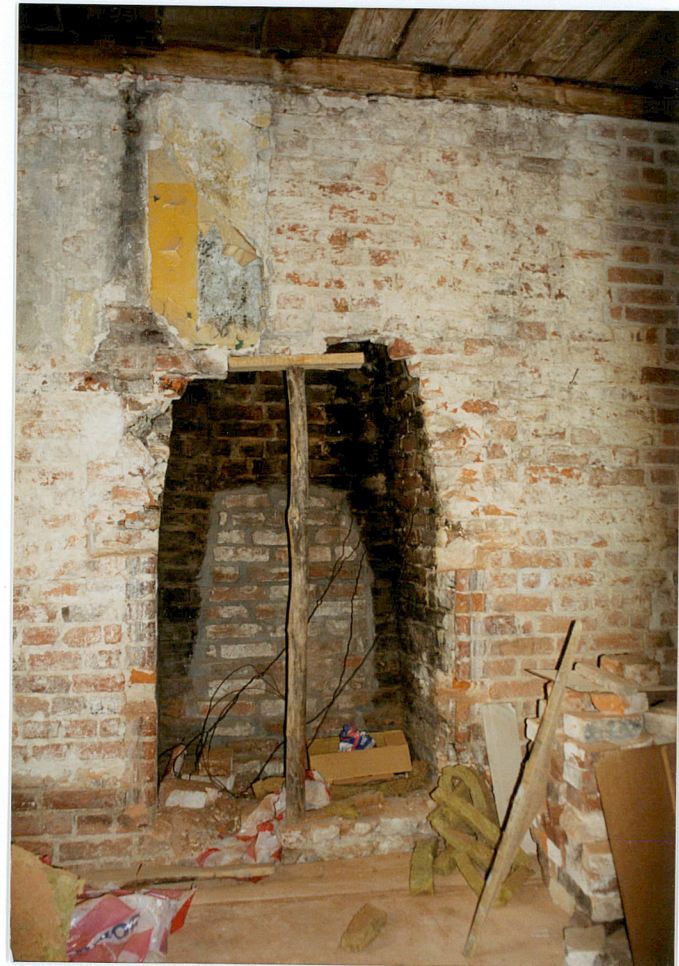
II piętro, mur wsch.. Częściowo zachowany gotycki kominek z profilowanymi pionowymi krawędziami.
