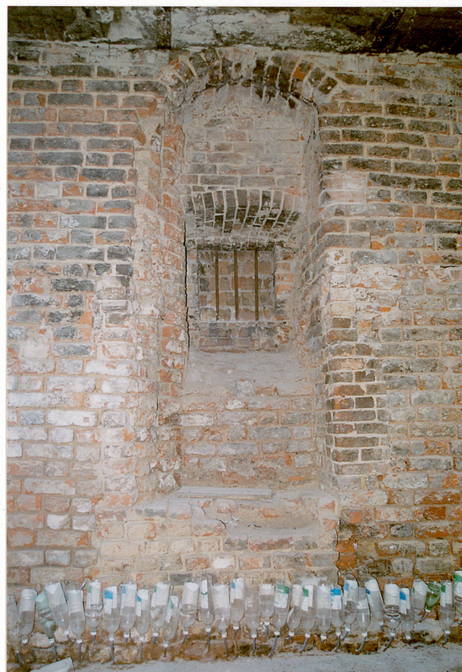
Poziom piwnicy, ściana zachodnia budynku południowego po usunięciu tynków. Okno w środkowej partii muru. (2003 r.)
