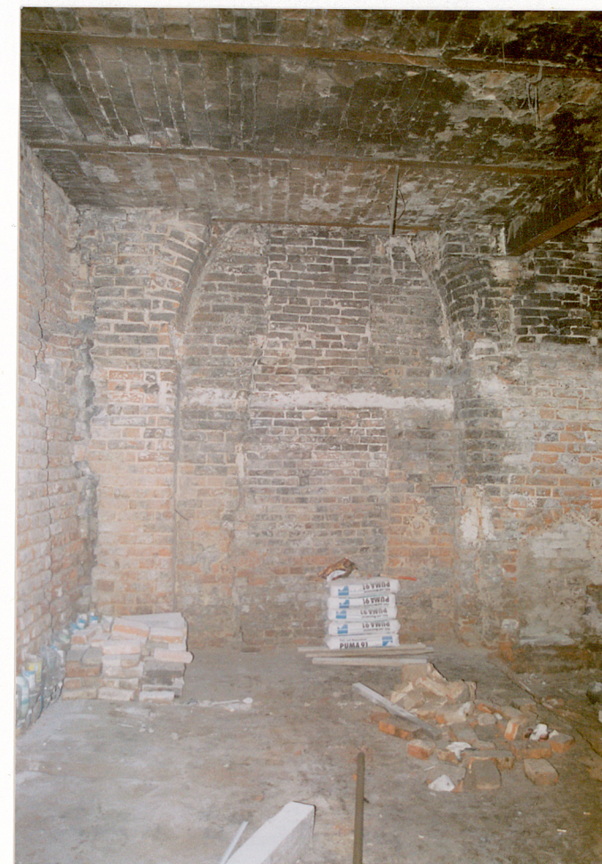
Poziom piwnicy, ściana południowa budynku południowego po usunięciu tynków. Odsłonięta arkada. (2003 r.)
