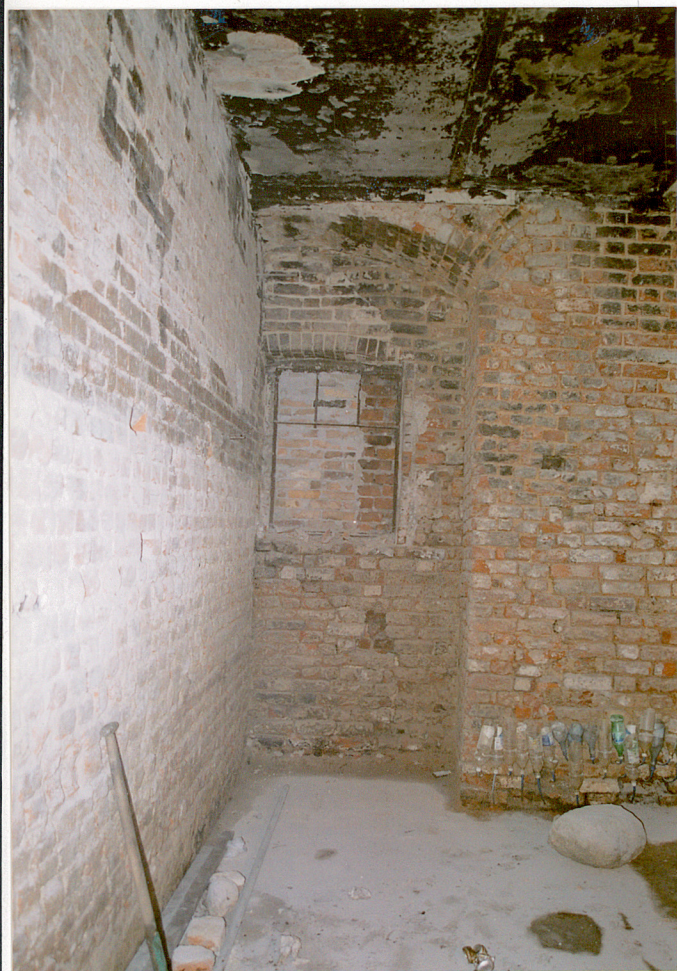
Poziom piwnicy, ściana zachodnia budynku południowego po usunięciu tynków. Fragment arkady muru. (2003 r.)
