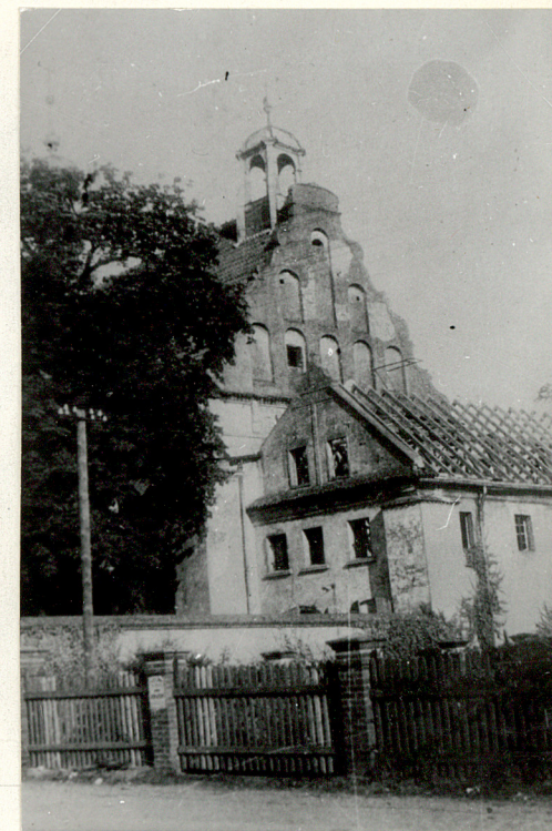
Nowa więźba dachowa nad skrzydłem zachodnim /1945r./ nr neg. 10341/1
