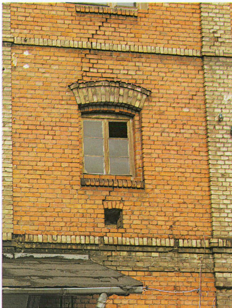
Główny budynek produkcyjny dawnego browaru Bojańczyka, pęknięcia muru w elewacji południowej, fot. Juliusz Raczkowski.
