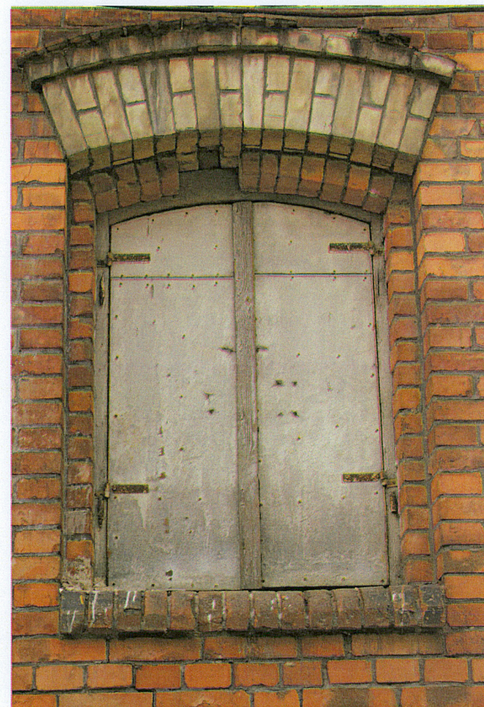
Główny budynek produkcyjny dawnego browaru Bojańczyka, detal architektoniczny z użyciem cegły sylikatowej, fot. Juliusz Raczkowski.
