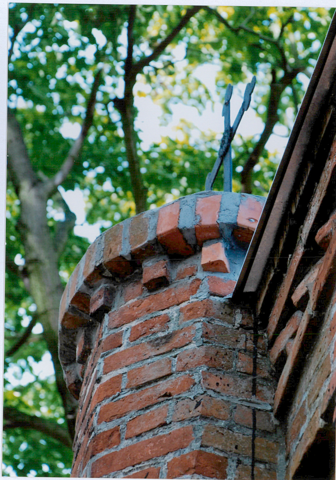
Uzupełnienie spoin w przyporze elewacji frontowej.
