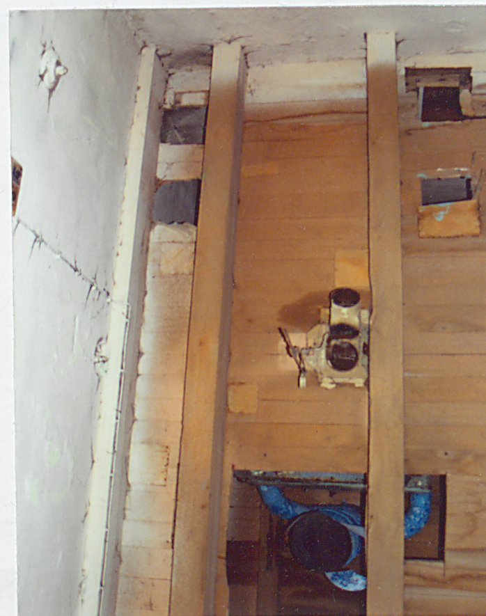
18. Pomieszczenie w południowej części przyziemia wieży technologicznej. Fragment stropu z zachowanymi otworami transportowymi.
