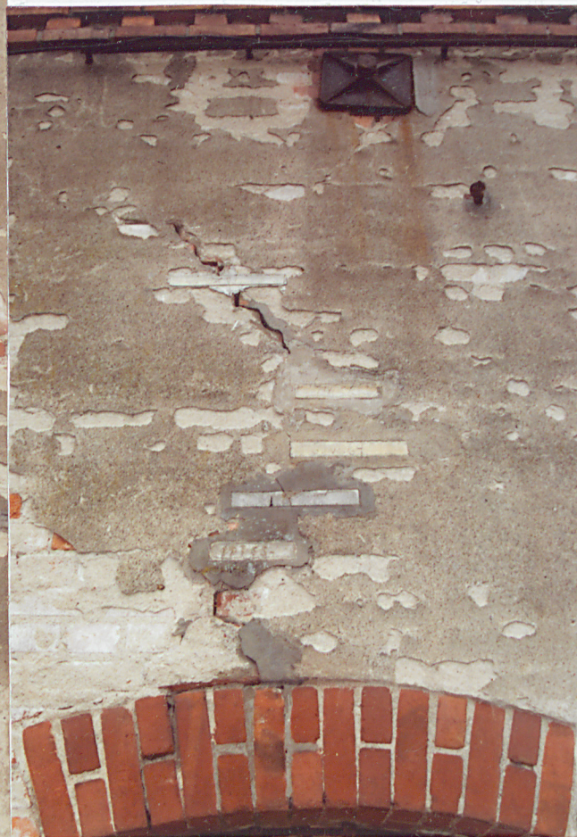
11. Fragment elewacji północnej. Widoczne szklane próbniki w miejscach pęknięć muru.
