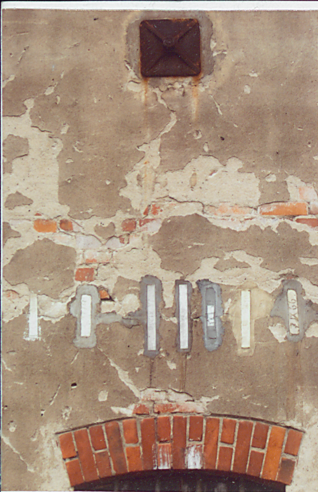
10. Fragment elewacji południowej. Widoczne szklane próbniki w miejscach pęknięć muru.
