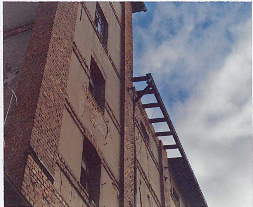
9. Fragment elewacji południowej. Widoczne ubytki pokrycia w połaci dachowej.
