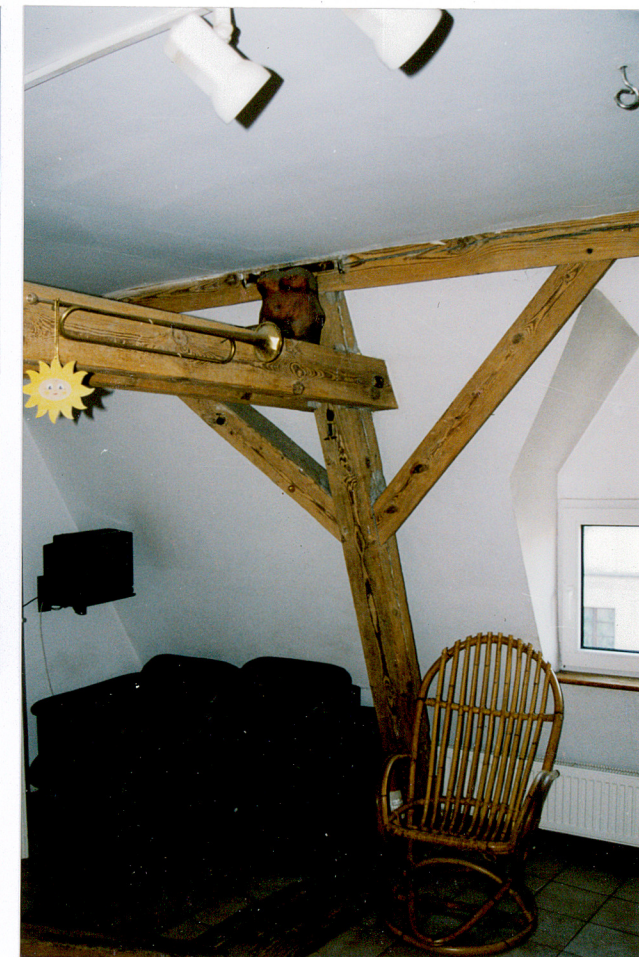
34. Stolec leżący usztywniony kleszczami i mieczami z płatwią w płaszczyźnie dachu od strony elewacji frontowej.
