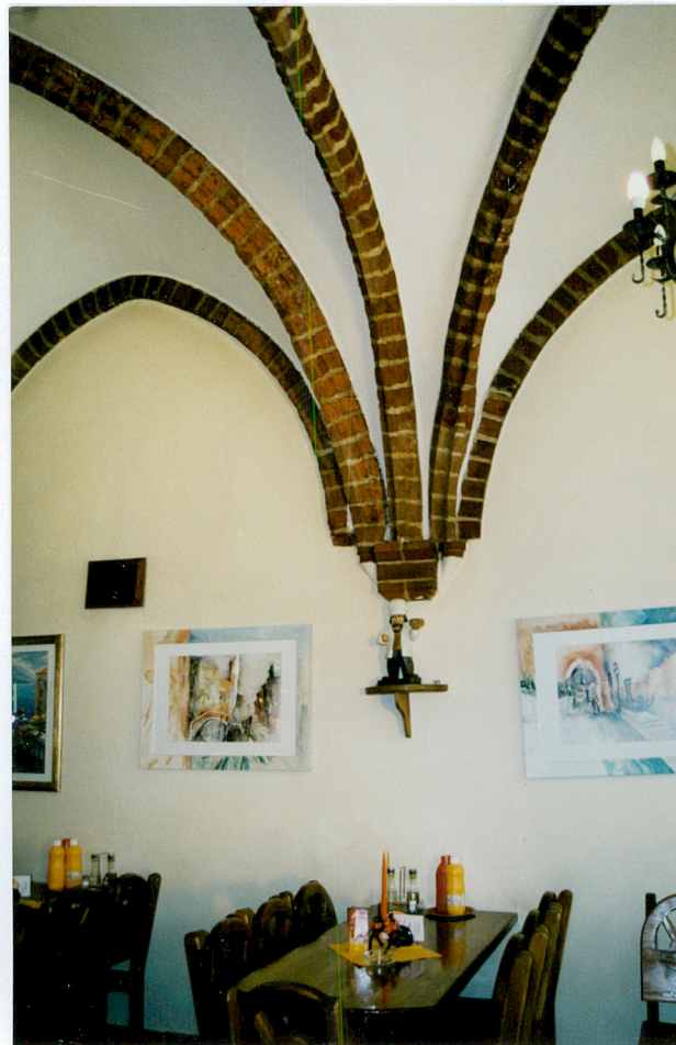
20. Konsola ceglana wspierająca służki żeber sklepiennych.
