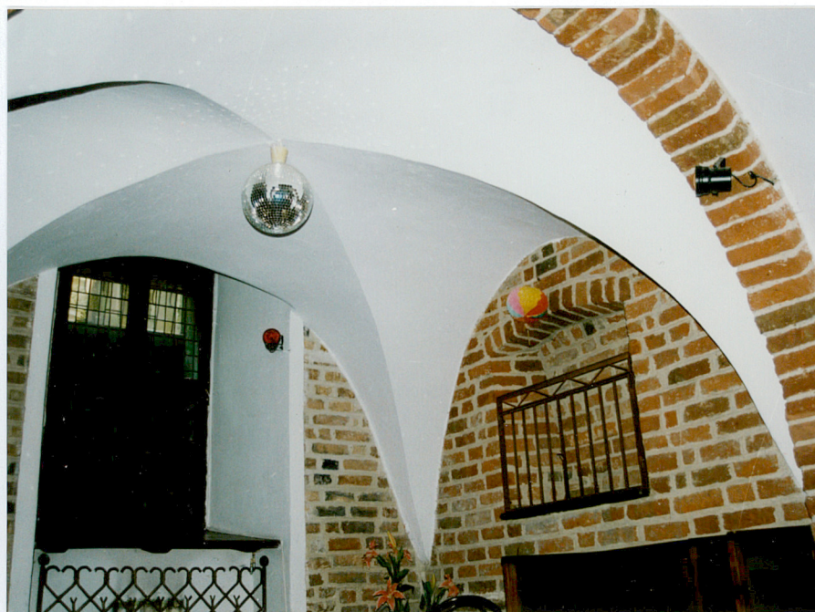
25. Przęsło krzyżowe sklepienia piwnicy w sąsiedztwie otworu szyi piwnicznej.
