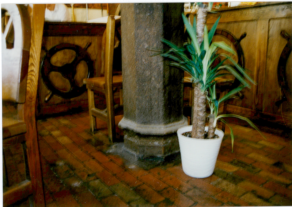
22. Profilowana baza granitowego słupa wspierającego sklepienie sali na parterze.
