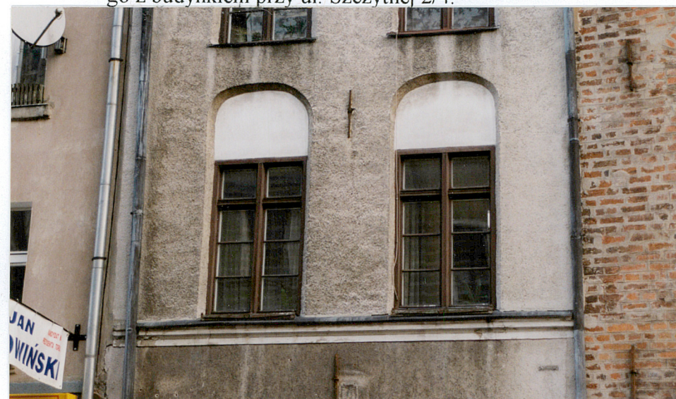
15. Nisze okienne zamknięte łukiem obniżonym. Widok na pierwsze piętro elewacji budynku sąsiedniego.
