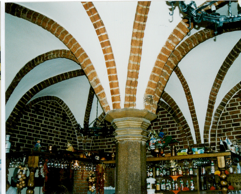
21. Głowica granitowego słupa wspierającego sklepienie sali na parterze.
