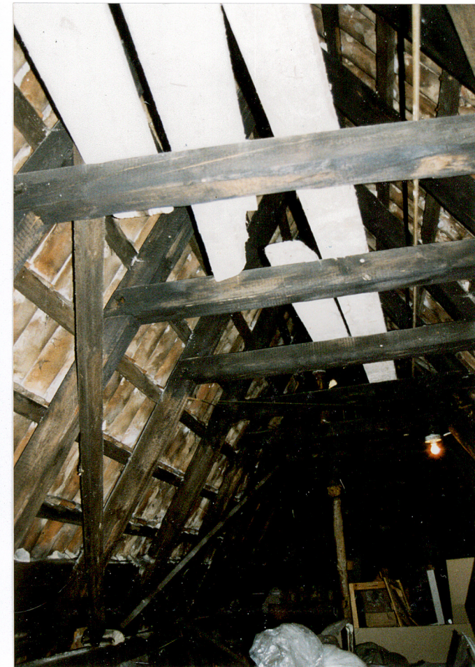
37. Wieszar krokwiowo – jetkowy. Widok ogólny więzby dachowej budynku sąsiedniego
