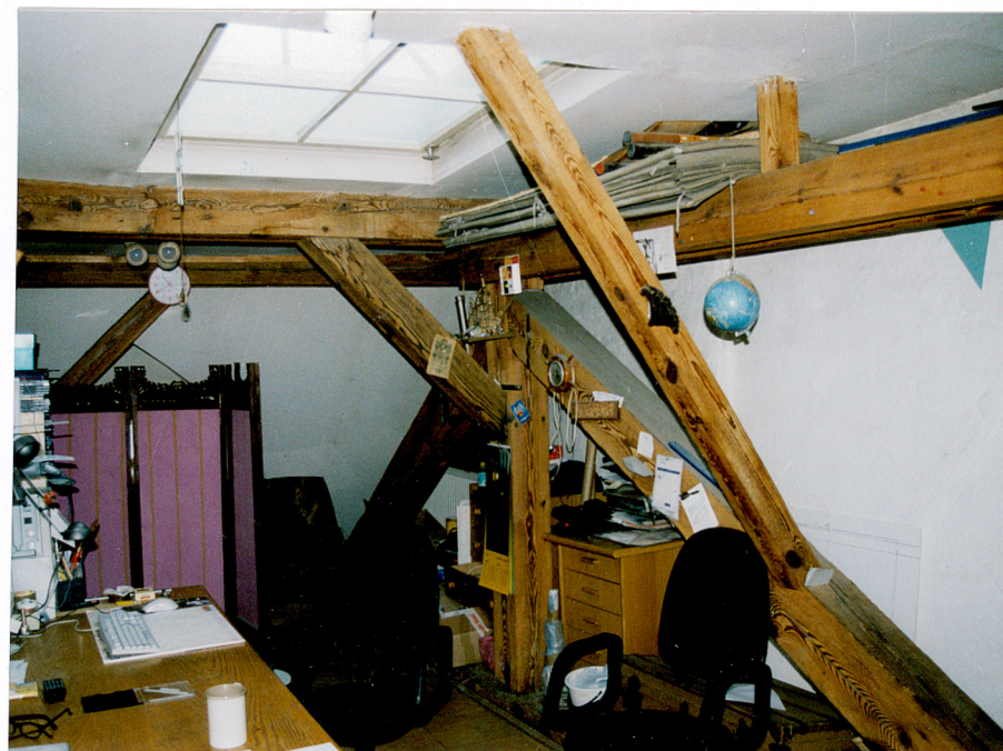
33. Wieszar więźby dachowej i rygiel usztywniony mieczem ze słupem wieszara.
