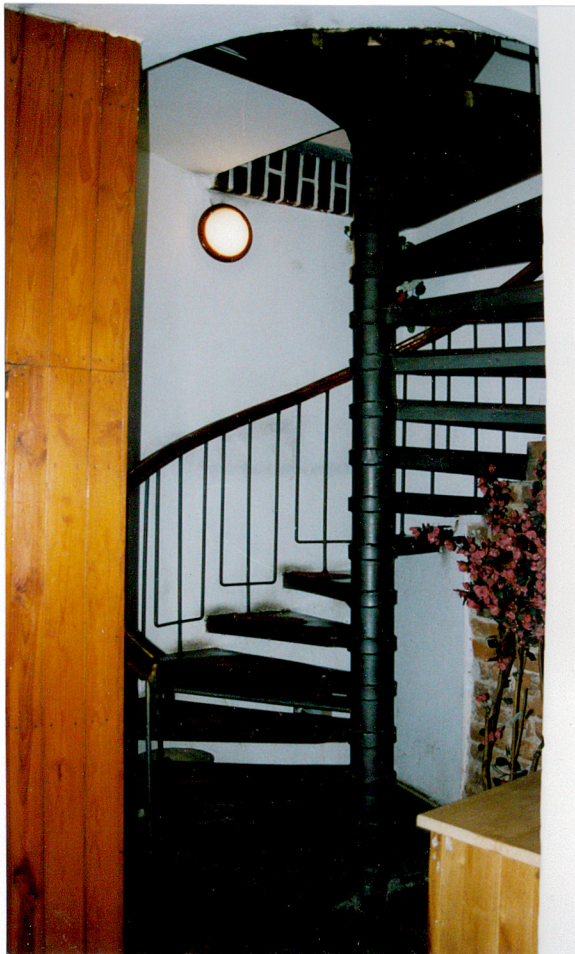
32. Schody kręcone z rdzeniem z parteru do piwnicy domu gotyckiego.
