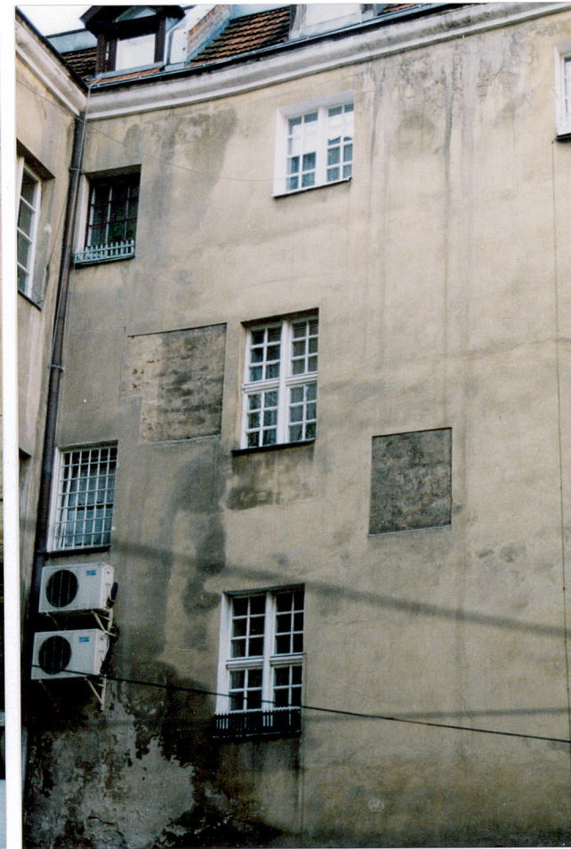
4. Osie okienne i odkrywki gotyckiego, ceglanego lica muru.
