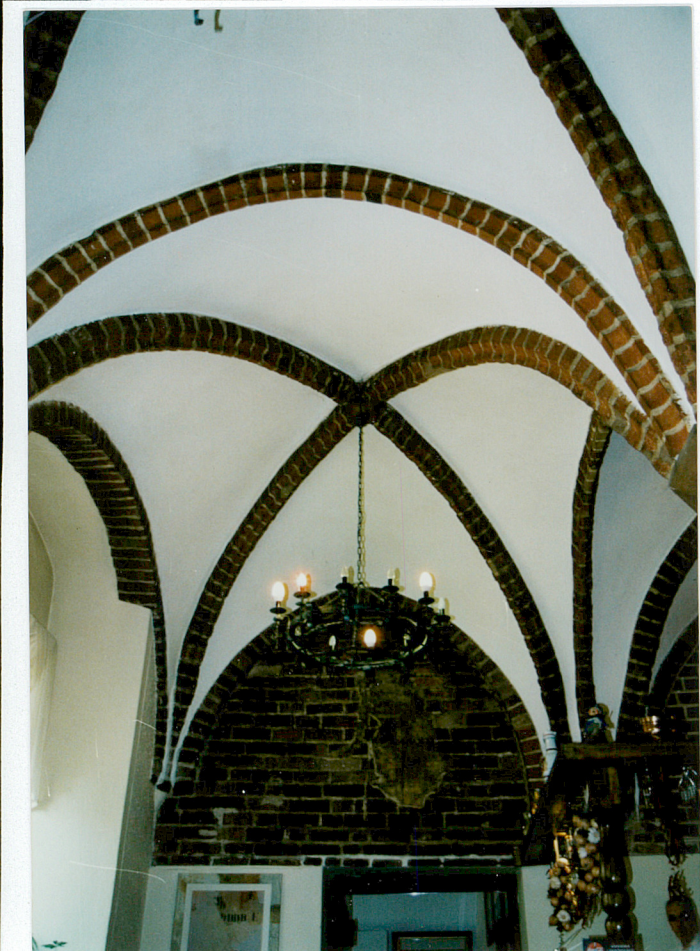
19. Widok przęsła sklepienia krzyżowo – żebrowego sali na parterze domu gotyckiego.
