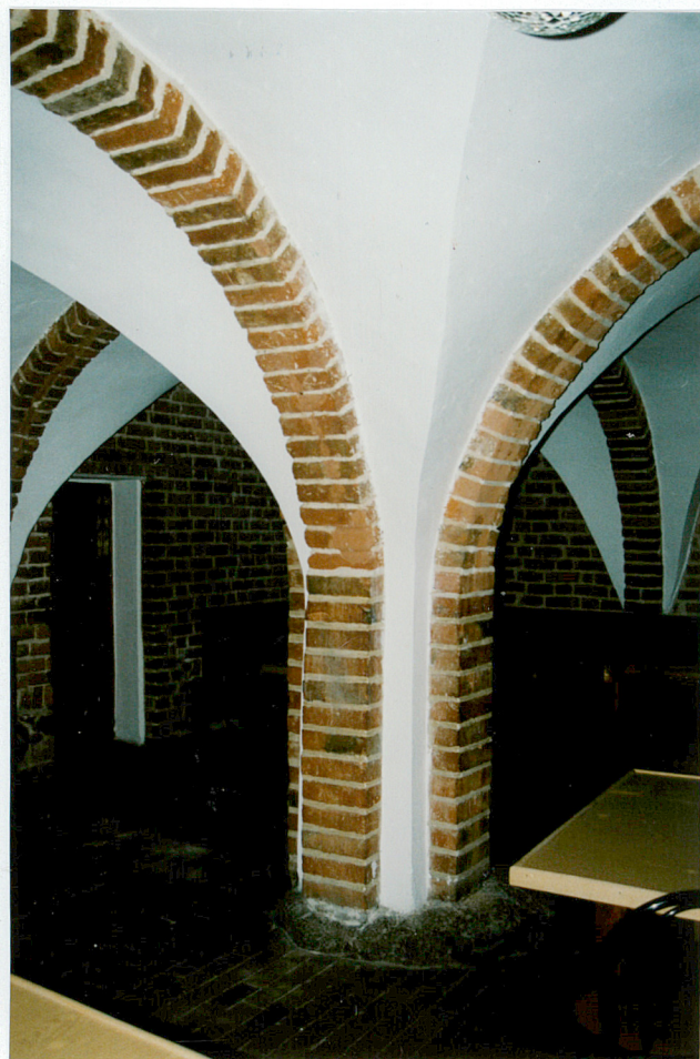
24. Filar ceglany wspierający sklepienie piwnicy domu gotyckiego.
