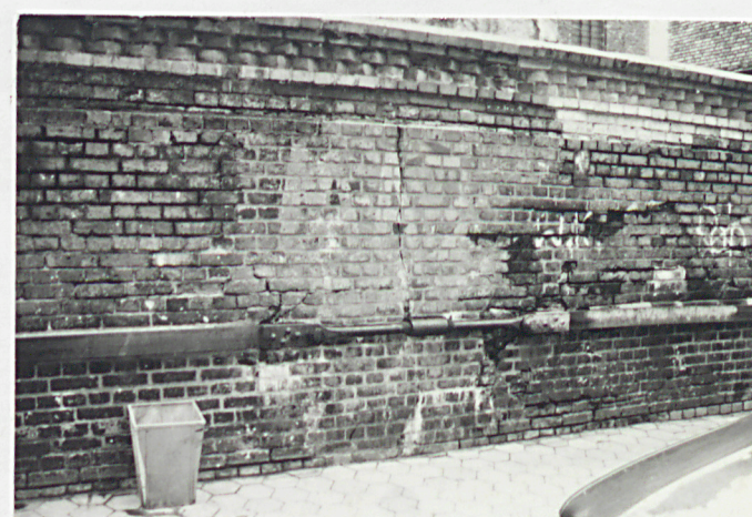
Ściąg stalowy ściany d. zbiornika środkowego
