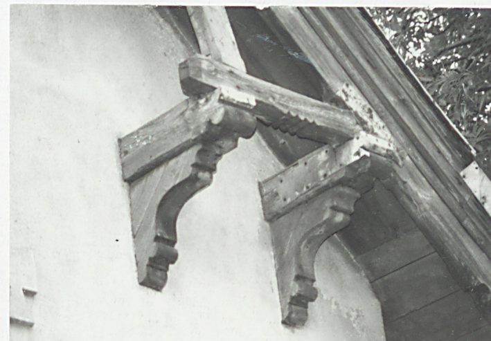
Dekoracyjne elementy drewniane wspiera- jące okap szczytu od frontu
