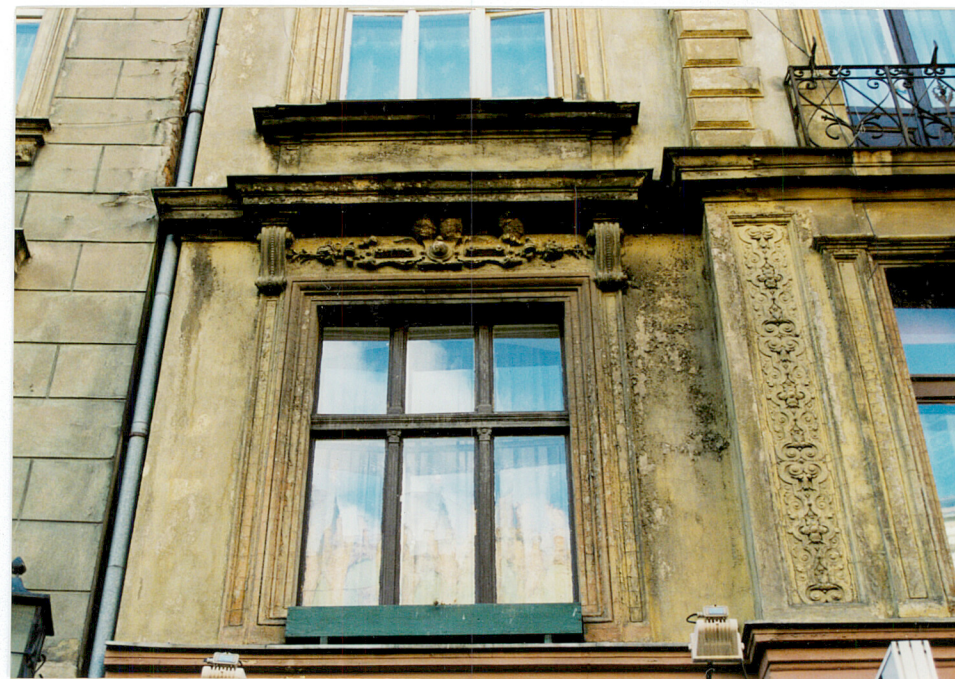
5. Detal architektoniczny obramień okiennych. Stolarka okienna z dekoracyjnym oparowaniem słupków okiennych w formie kolumn korynckich.
