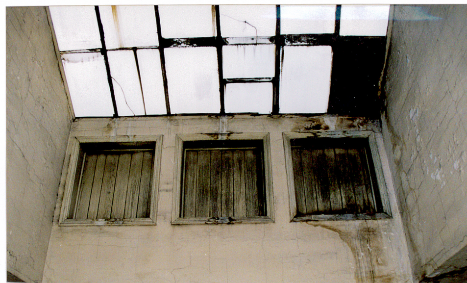
12. Światlik klatki schodowej w połaci dachu pulpitowego.
