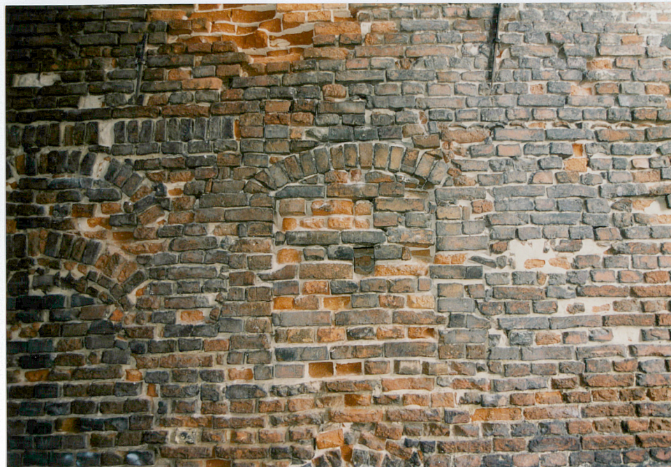
14. Zamurowane otwory okienne na parterze elewacji pd.
