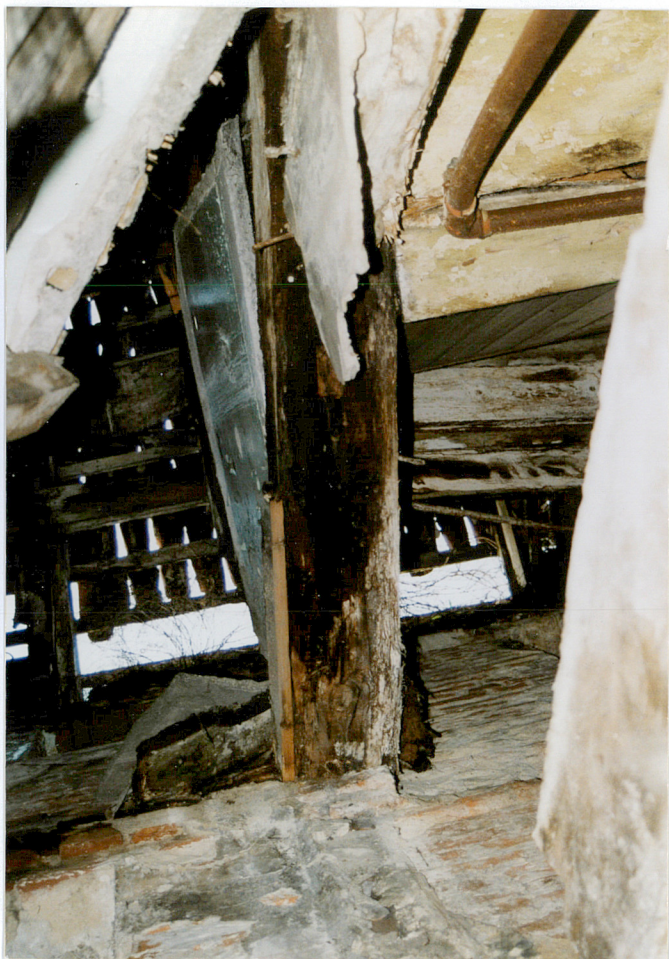
23. Widok na zarwane stropy w kierunku dachu dawnego spichrza.
