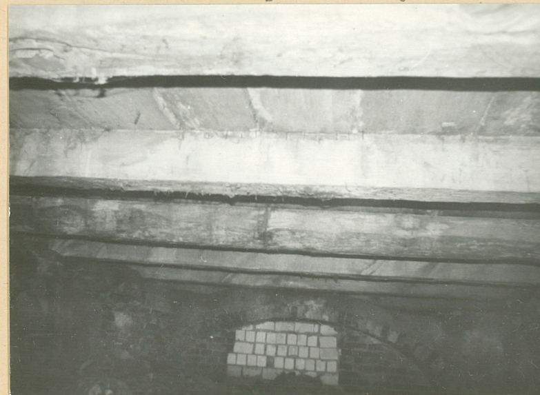
Piwnice - strop belkowy nagi
