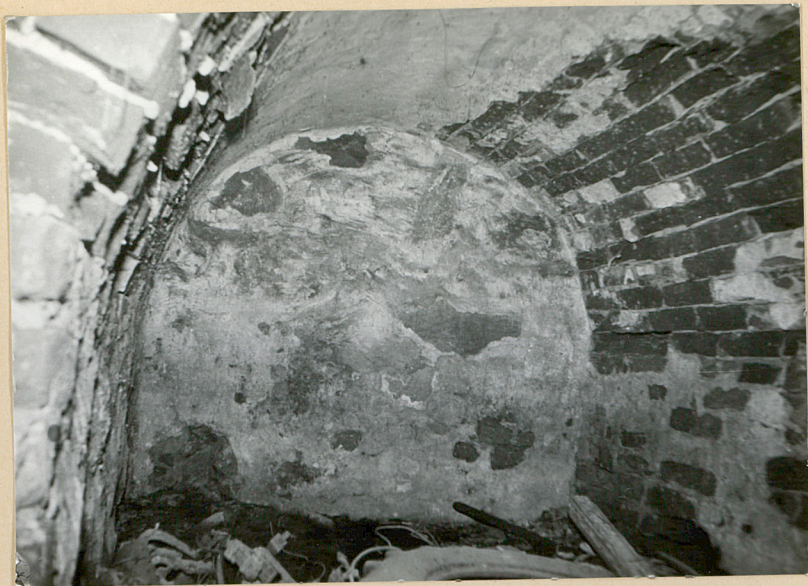
Piwnice - strop kolebkowy
