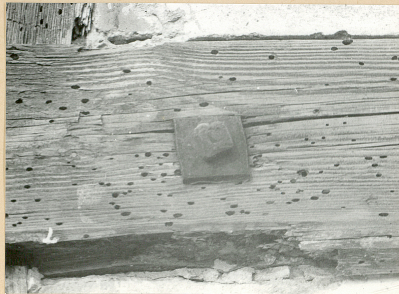
Łączenie belek szkieletowych
