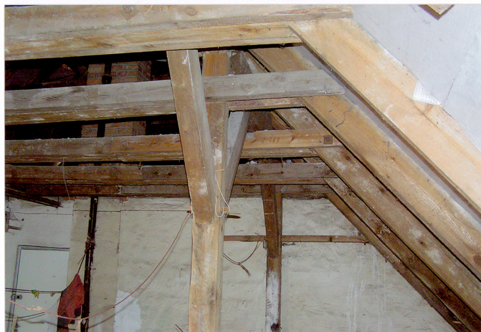
il.43, 44. Fragment więźby dachowej o konstrukcji płatwiowo-kleszczowej.
