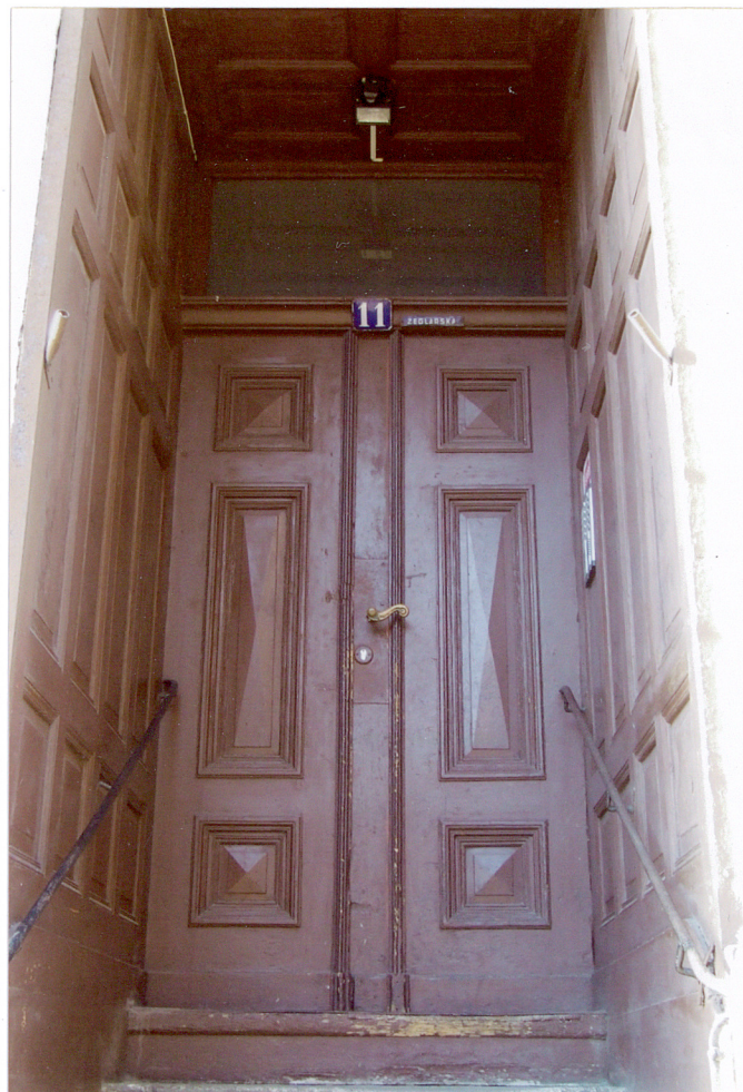
il.10. Drzwi główne o konstrukcji ramowo płycinowej z szerokimi dekorowanymi ościeżami.
