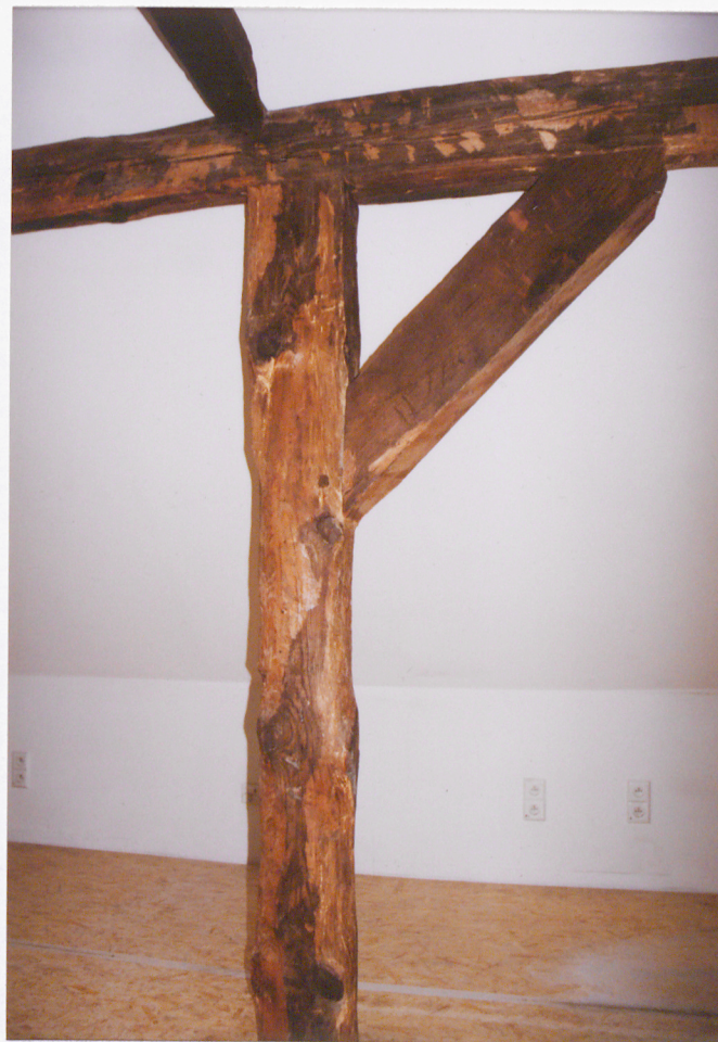
Poddasze. Fragment konstrukcji więźby.
