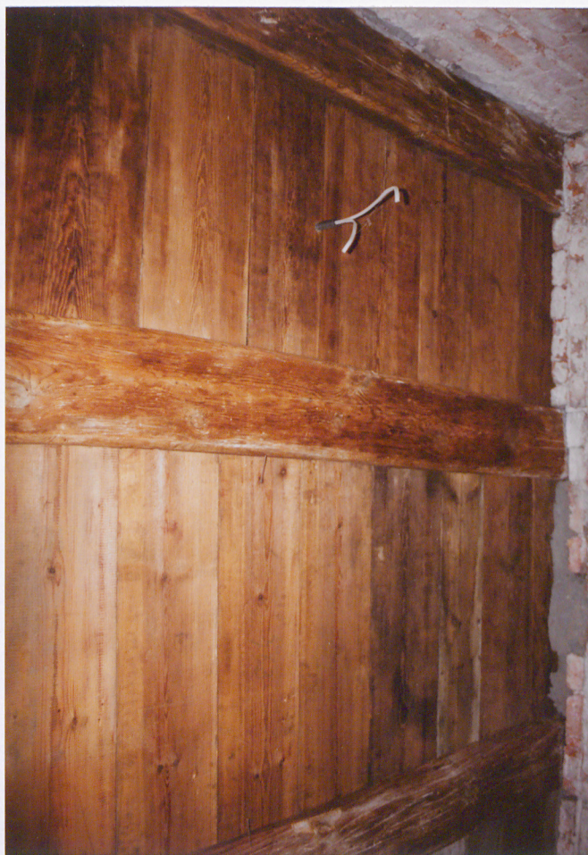
Parter. Fragment stropu belkowo-wsuwkowego.
